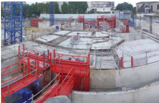
Recouvrement du rez-de-chaussé du bâtiment C avec des dalles alvéolaires précontraintes
