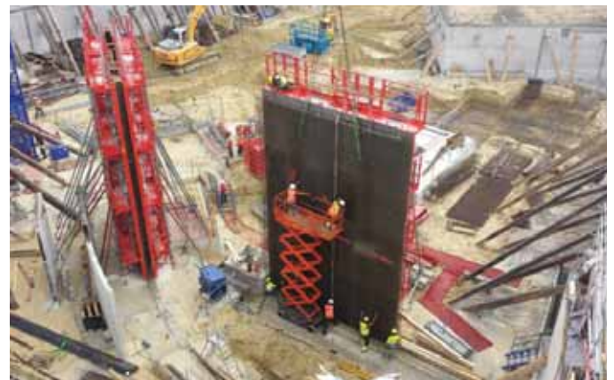
Coulage des 1 ères murs de grande hauteur
